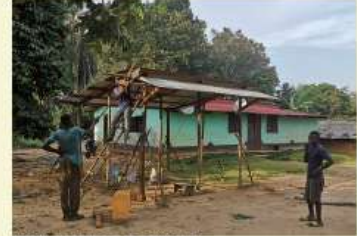
蜂蜜加工場建設工事の始まり
