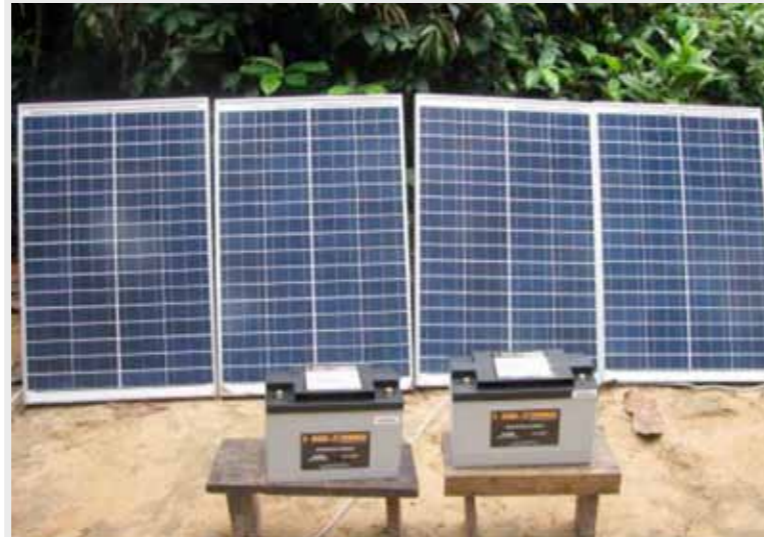
写真1. 新たに設置したソーラーパネル4枚とバッテリー2台 © WCS コンゴ共和国
